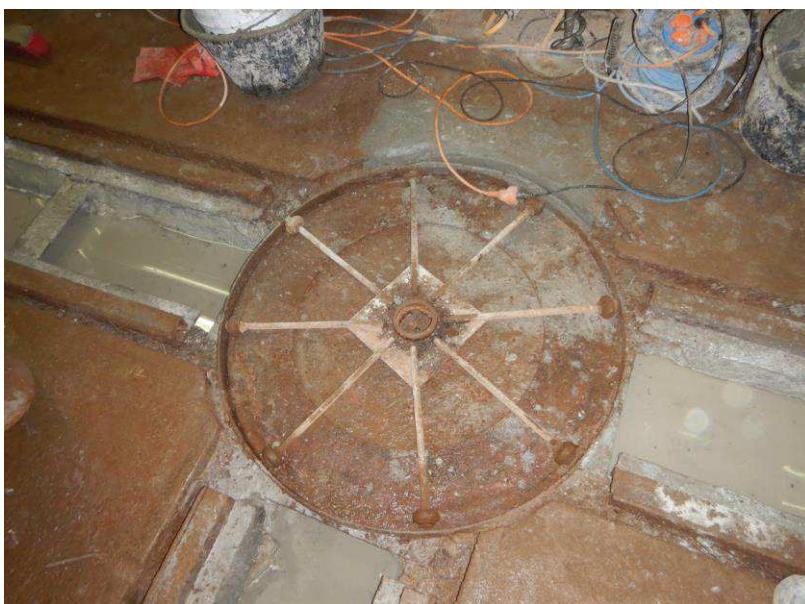
Obrázek 1 Točna pod šachtou Š5 (projektant předpokládá podobnou konstrukci točny v TG11)
